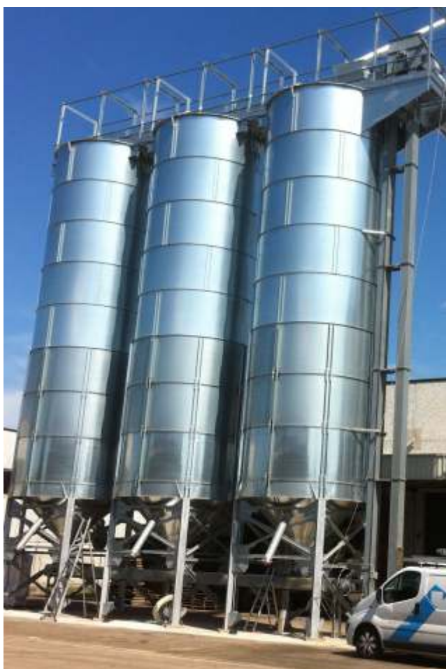
Sili lisci bullonati, su singoli pilastri.
