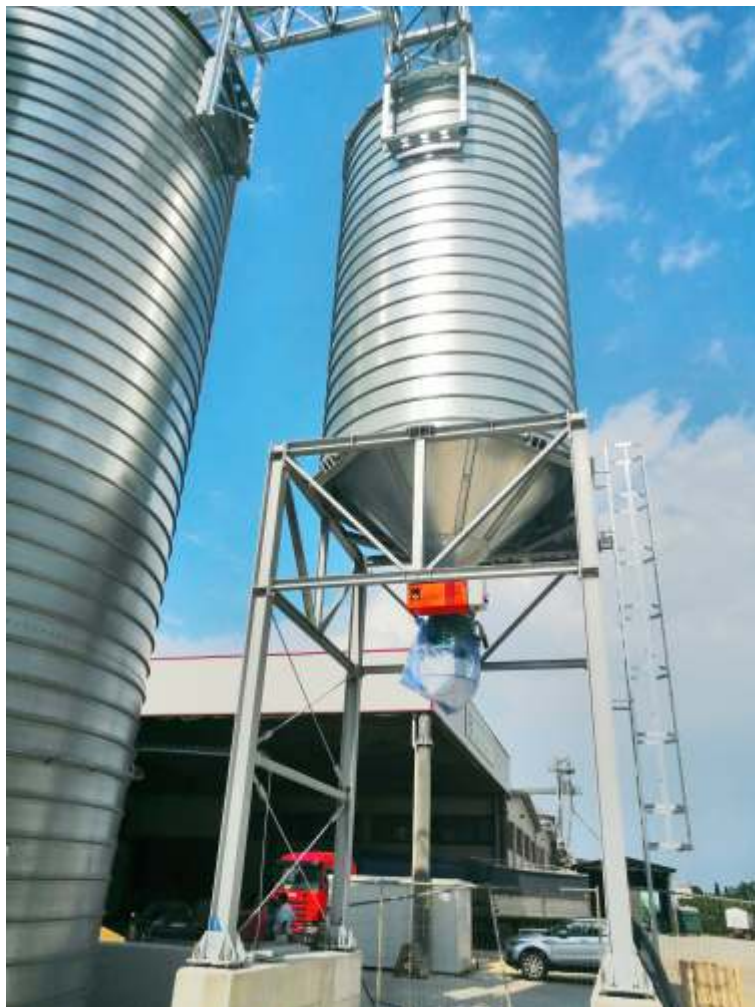
Silo liscio spiralato tramoggiato, su struttura metallica per carico rapido alla rinfusa.
