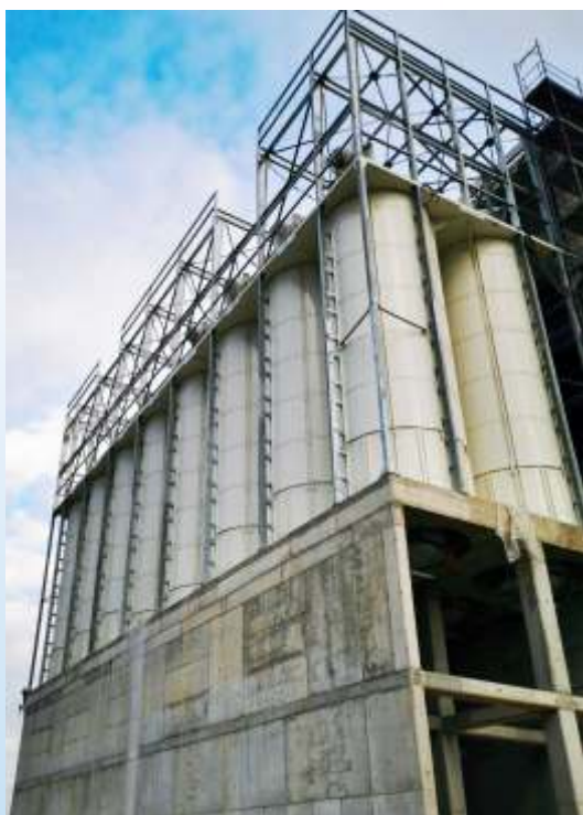
Sili lisci bullonati verniciati, in batteria, su struttura in cemento armato.
