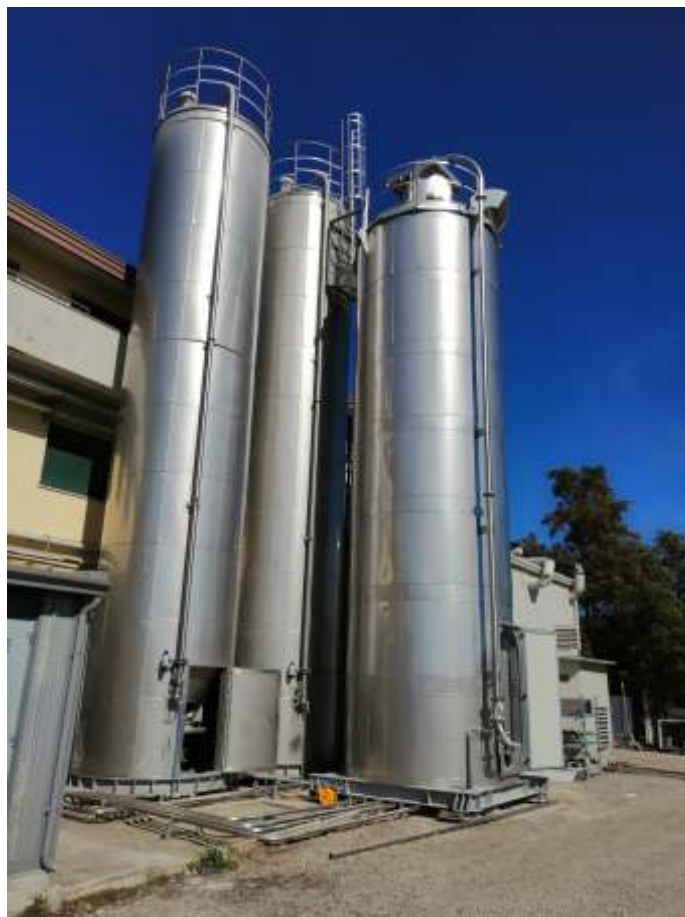
Sili lisci bullonati INOX su gonna, coibentato singolarmente, per scarico autocisterna .
