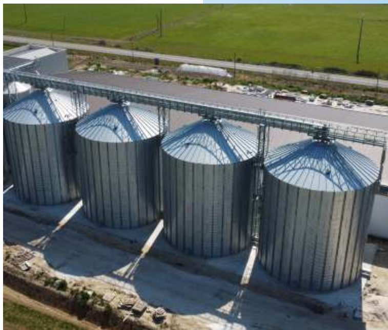
Sili ondulati bullonati, fondo piano.
