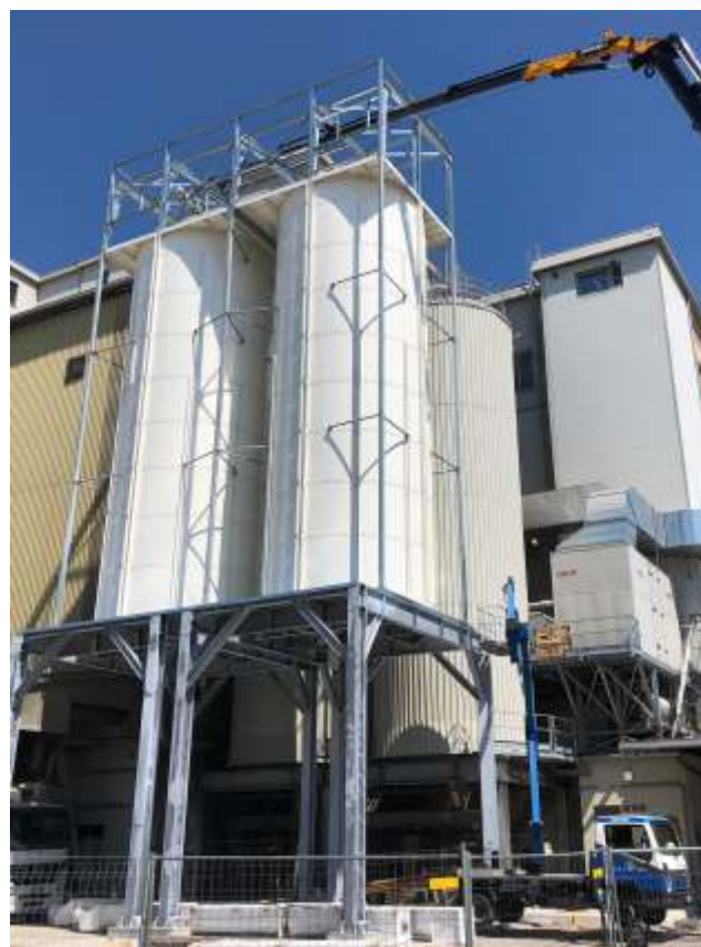
Sili lisci bullonati verniciati, con fondo piano ed estrattore per prodotti di difficile scorrimento, su struttura metallica per carico rapido alla rinfusa.
