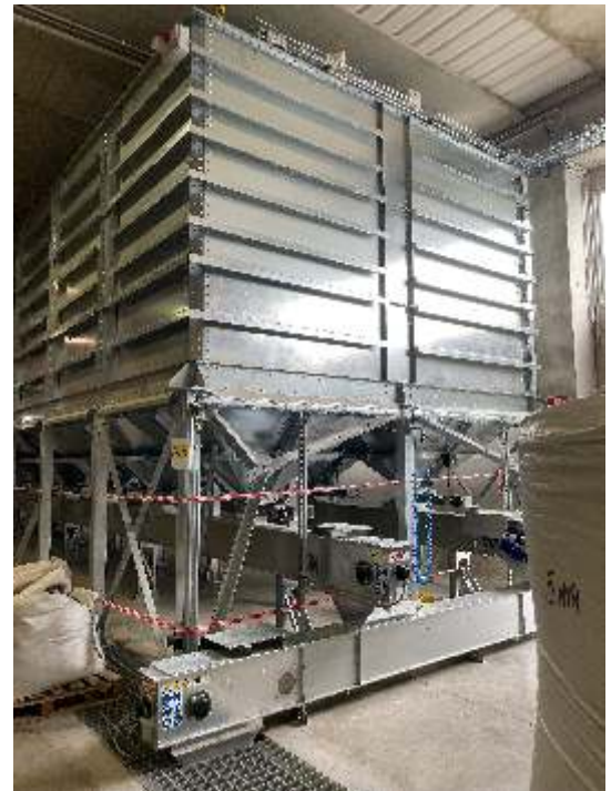
Batteria di celle a parete liscia con rinforzi a vista, su struttura metallica interna a capannone.
