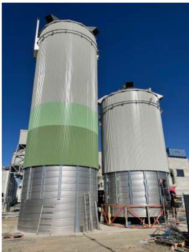
Sili lisci spiralati INOX fondo piano, coibentati singolarmente.
